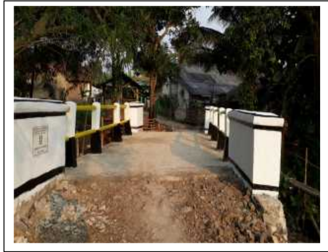
Gambar 3.4 Pelebaran Jembatan Nyompok Desa Nyompok
