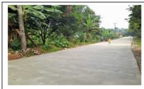
Gambar 3.2 Rekonstruksi Jalan Kadugenep – Panunggulan (DAU)
