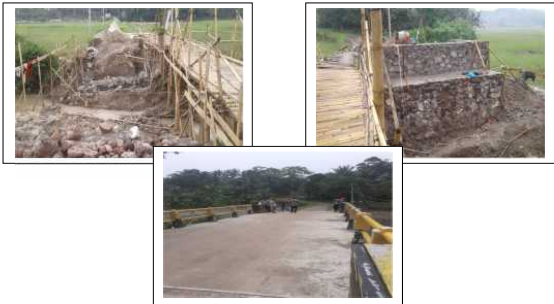
Gambar 3.5 Pembangunan Jembatan Sukaratu Tahap 2
